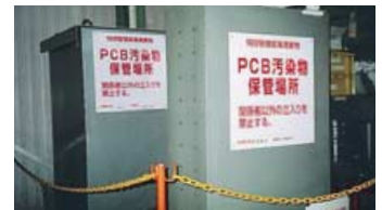
新川工場PCB廃棄物保管状況
