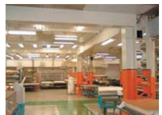
新川工場建物のH鋼による補強
