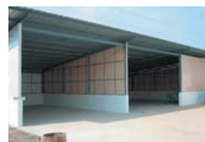
新設された廃棄物保管倉庫
