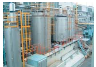
新川工場樹脂タンク基礎部分のコンクリートによる補強
